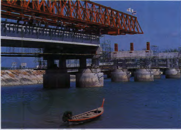
الجسر الحديدي نموذج من الجسور العرضية التي تعطي مزيداً من القوة نظراً لاستخدامه المثلثات. ويتم بناء هذا الجسر، الآن في تايلاند.
