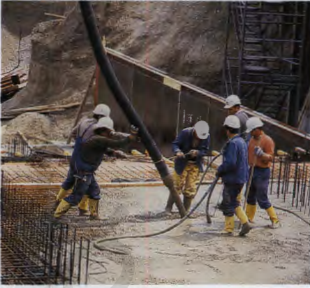
تصب الخرسانة فوق أسياخ الصلب لتقويتها.
