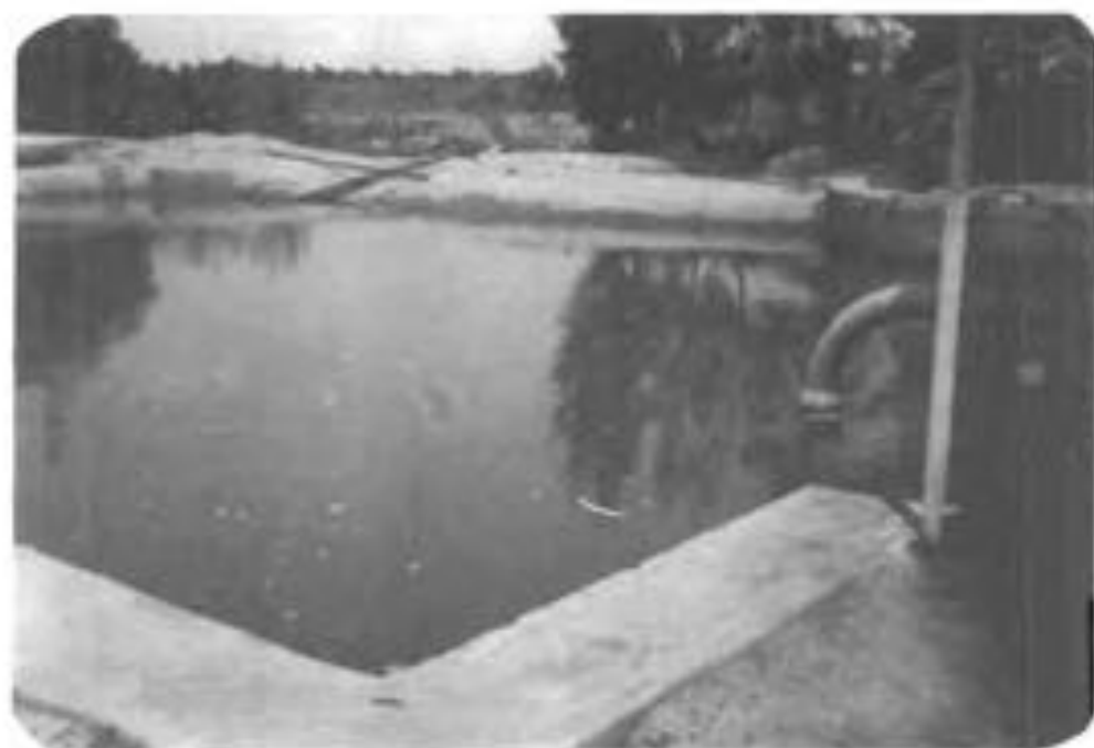
شكل ٢٢ - ٦ : بركة لتخزين المياه اللازمة لري مجمع من البوت الحمية .
