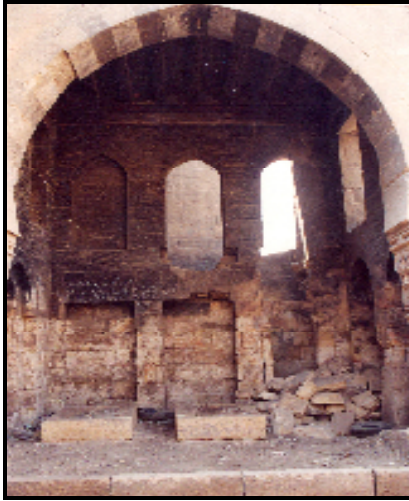
لوحة ١٦ - الإيوان الجنوبي الغربي للرباط - قبل الترميم
