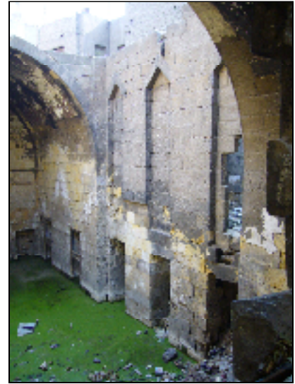
لوحة ٣٧ - الجزء الجنوبي الغربي لرباط زوجة إينال
