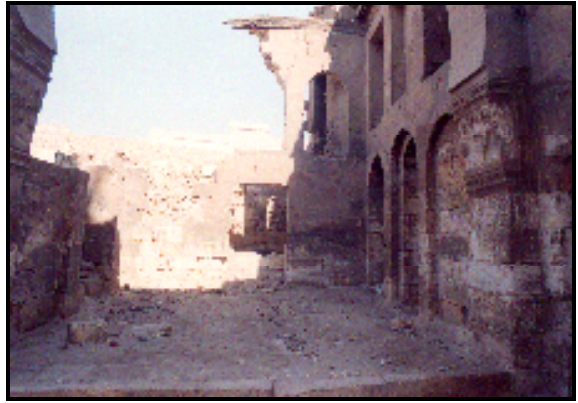
لوحة ١٩ - الإيوان الشمالي الشرقي للرباط قبل الترميم
