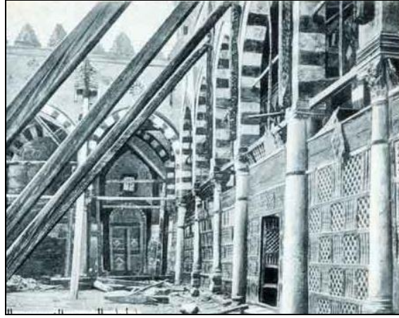
(لوحة ٢) جامع الطنبغا المارداني بالتبانة - قبل الترميم- صلب عقود بانكات الصحن والرواق الشمالي الشرقي عن كراسات اللجنة - مجموعة ٢٢ سنة ١٩٠٥م
