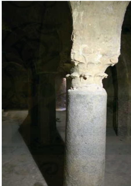
بقايا أعمدة فئار الإسكندرية داخل المسطح الأول "الأرضى"
