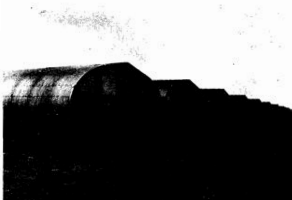
شكل ١ - ٢ : مجمع من البيوت المحمية المتصلة بنظام الخطوط والقنوات ، والكون من وحدات من الشكل النصف دائري المحور ذات سقف غير تام الامتدادة .
