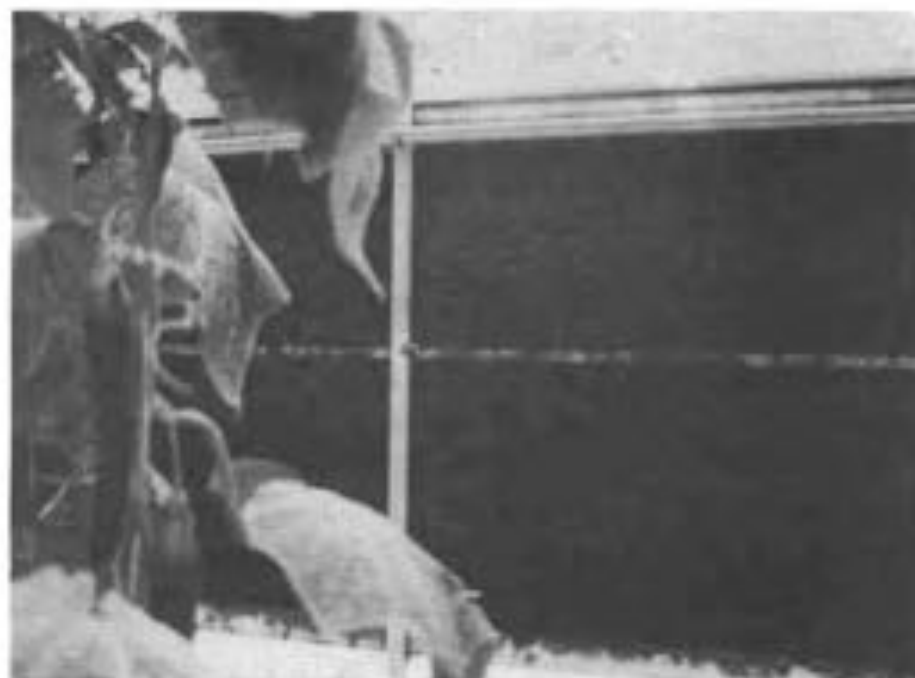
شكل ٢ - ١٥ : وسائد التبريد وهي مثبتة في مستوى النمو النباتي .
