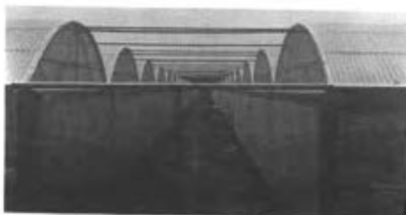
شكل ٢ - ١٣ : المراوح الساحية للهواء البت وهي مثبتة في الحدا
