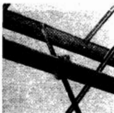
شكل ٢ - ٢٧ : نظام التحكم في فتح وغلق منافذ التهوية بإدارة عجلة خاصة تتصل مع فتحات التهوية بتروس ، ويمكن تشغيلها آلياً ( عن H.A.G. انجلترا ) . يلاحظ نفس النظام أيضاً في شكل ( ٢ - ١٩ ) .
