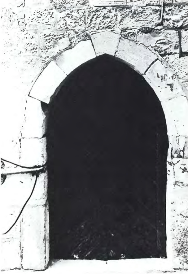
مدخل الزاوية وتظهر فيه التشققات بالحجر
