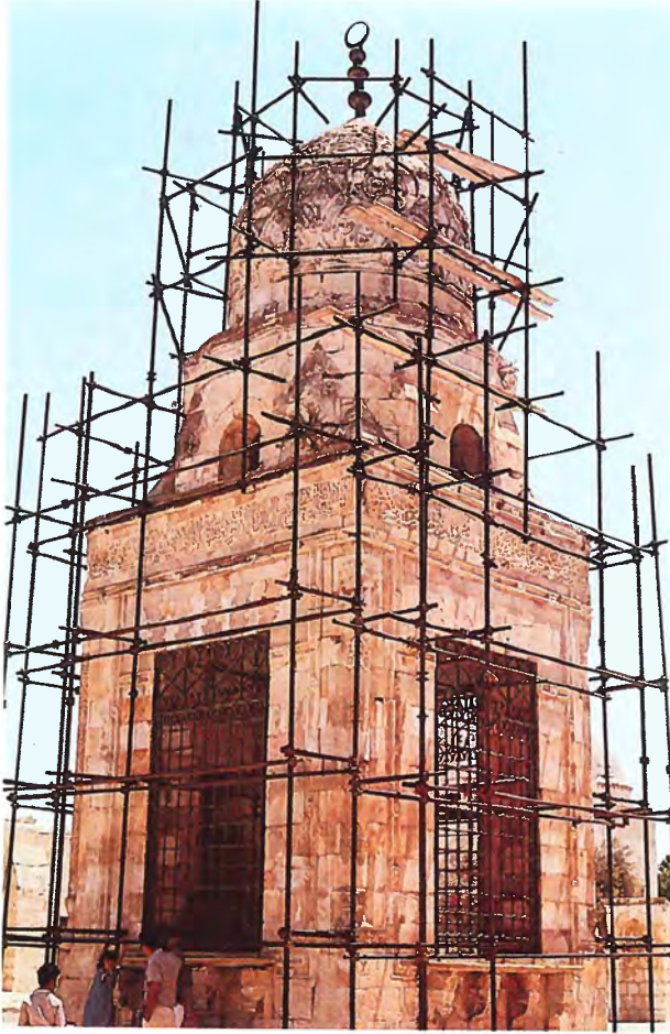
السبيل وحوله سقالات الترميم
