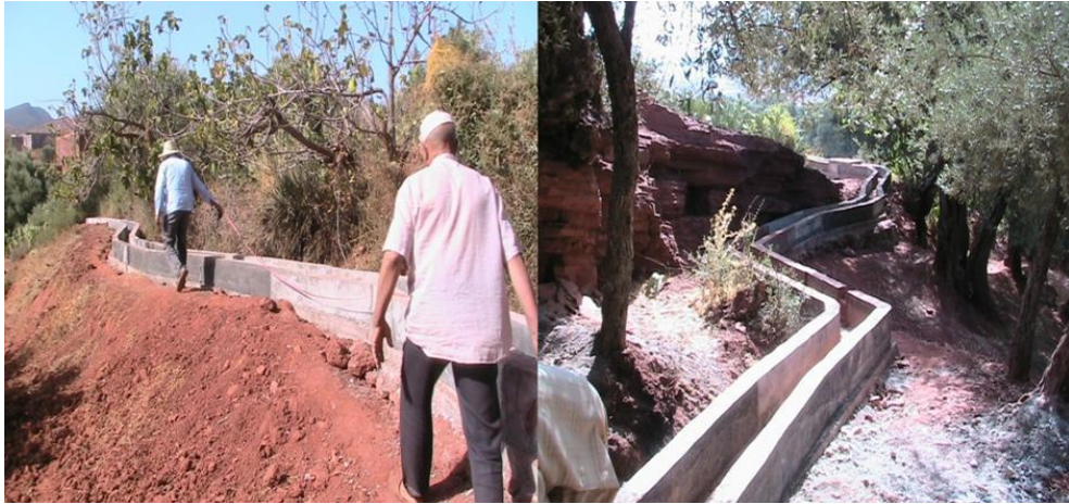
Planche photo 5: Après la réalisation des travaux d'aménagement au ciment de la Seguia au douar Taghbaloute, l'eau devient disponible 24h/24h avec des quantités suffisantes et parfois mêmes excédentaires aux besoins du Douar.
