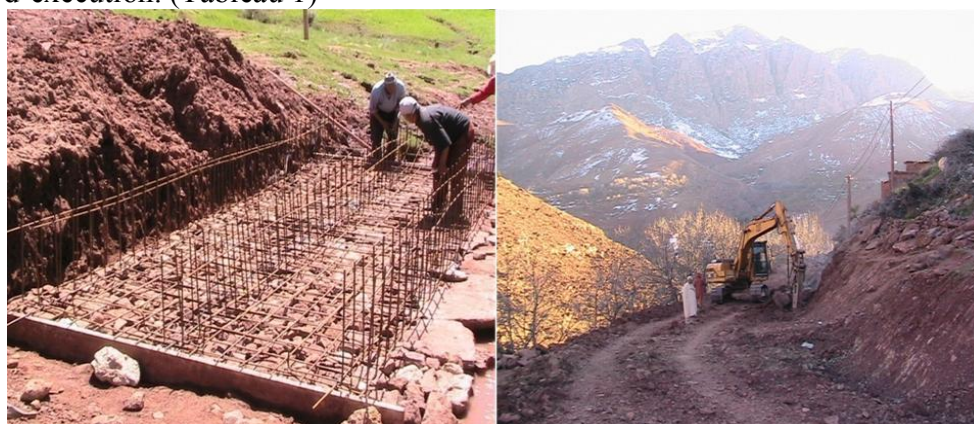
Planche photo 1: Aménagement de piste qui relie douar TAGNIT et douar ASLAK facilite le transport et réduit l'enclavement de sa population. (2011)
