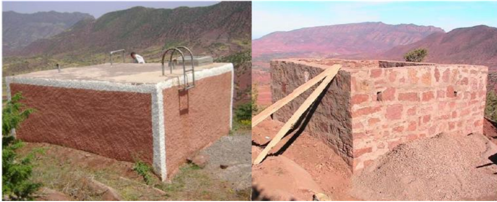
Planche photo 3 : la construction de château d'eau à douar Ikhachane, construction destinée à entreposer l'eau, placée en général sur un sommet géographique pour permettre de la distribuer sous pression
