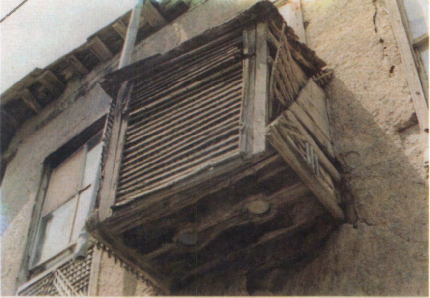
مشربية مكعبة في حي العمارة البرآنية وتشاهد في أسفلها فتحتان لوضع جرار الماء بهدف التبريد .
