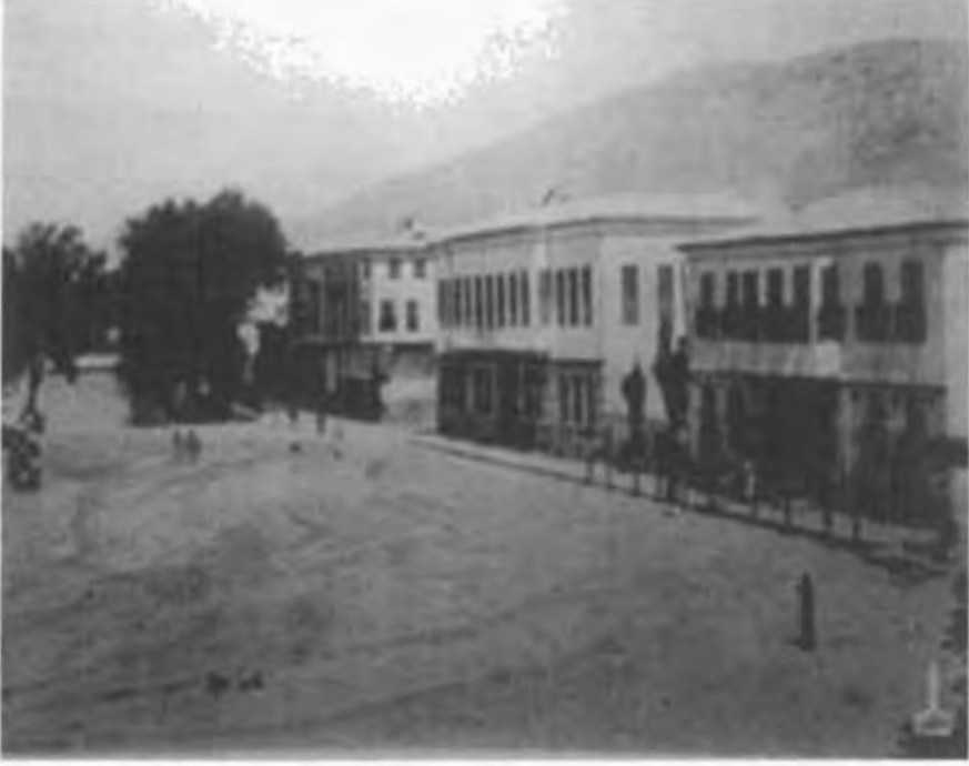
صورة للمنشآت والمباني في ساحة الشهداء
