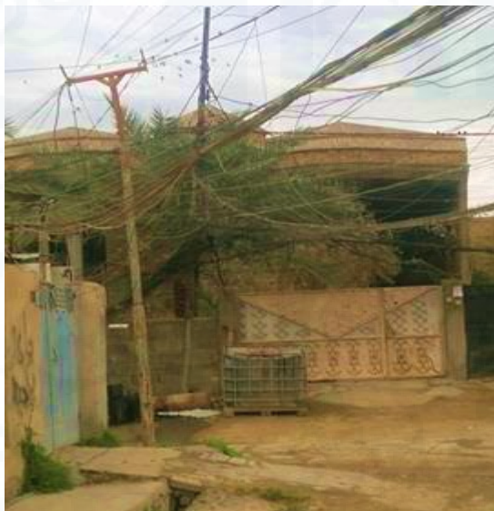
صورة (١٤) مؤشر الاسلاك الكهربائية للمولدات الاهلية
