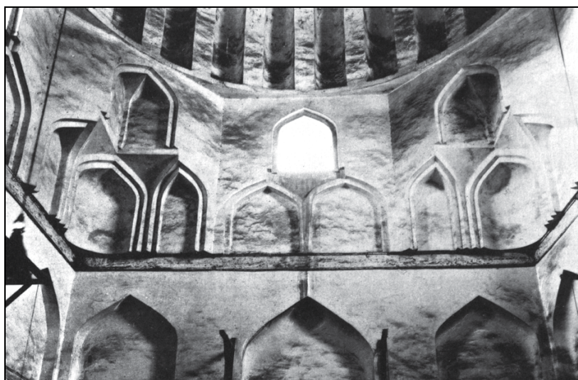
قبة مشهد يحيى الشبيهة من الداخل : مناطق الانتقال
