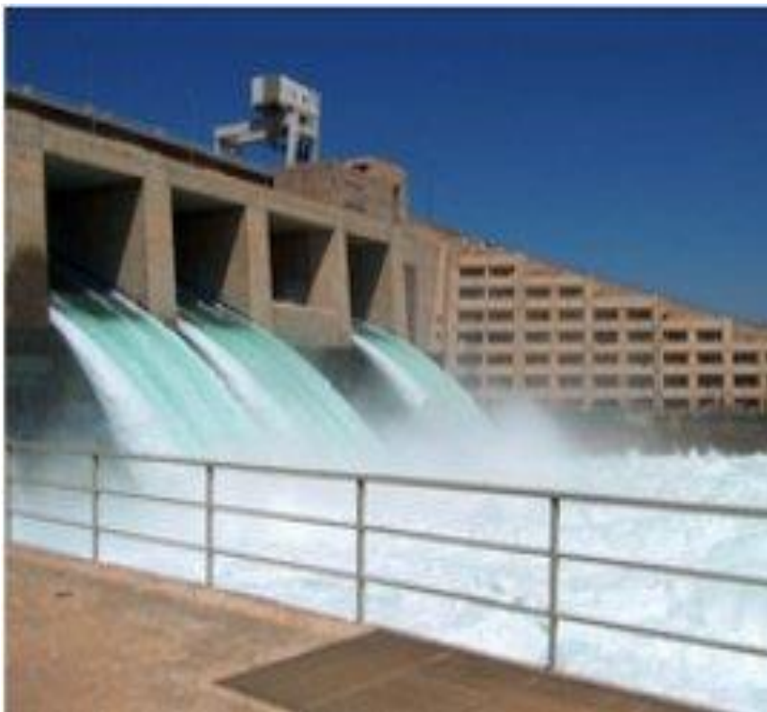
شكل رقم (2) سد حديثة في مناسب المياه العالية في خزان البحيرة لسنة 2019
