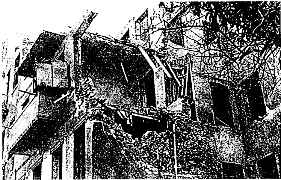
الشكل ٨٣ - أبنية متضررة في منطقة القاهرة القديمة مبنية من الجدران الحجرية الحاملة والأسقف الخشبية غير المربوطة (المصدر ٩٣).
