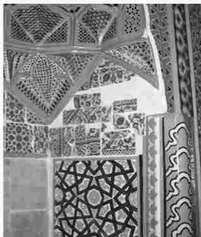
أعمال ترميم في قونيا
