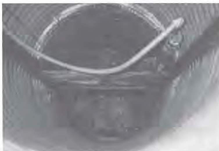
الشكل رقم (١٨, ١٠). بناء التحكم المستخدم لقياس تدفق الصرف والتحكم في منسوب المياه في كاليفورنيا.
