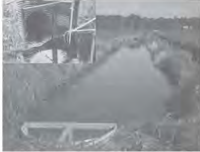
الشكل رقم (١٨،٢). رافعة المعارضة عند قمة الهدار من النوع الذي يتم استخدامه في المصرف المكشوف. ومن الممكن أن يكون هناك حاجة لفترة زمنية طويلة لرفع أو خفض منسوب الماء الأرضي في القناة طبقاً لحجم القناة.
