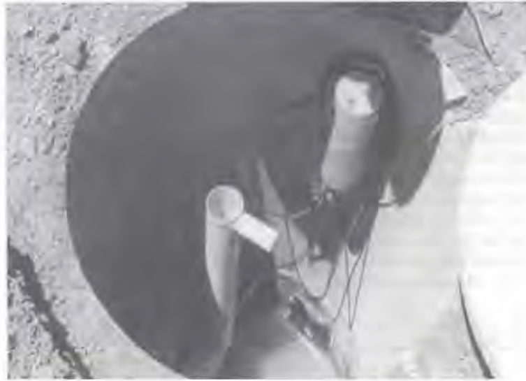
الشكل رقم (١٨,٩). بناء التحكم في الخط الفرعي الفردي المستخدم للتحكم في منسوب الماء الأرضي في كرمة بأستراليا.
