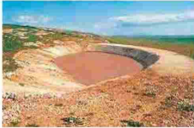
الشكل رقم (٢٣، ٦). حفرة تخزينية كبيرة لحصاد المياه في الأودية لأغراض متنوعة.
