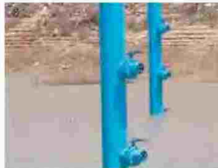
الشكل رقم (٦، ٢٥). تغذية المياه الجوفية باستخدام أنابيب التغذية الصناعية.
