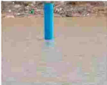
الشكل رقم (٦، ٢٥). تغذية المياه الجوفية باستخدام أنابيب التغذية الصناعية.
