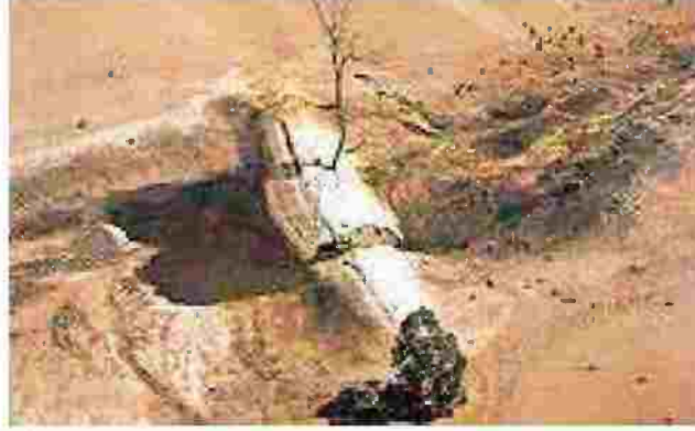
الشكل رقم (٢١, ٦). سد ترابي صغير انهار نتيجة عدم كفاية المفيض (المسيل).
