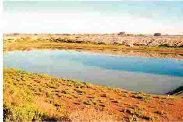
الشكل رقم (١٥, ٦) منطقة تجمع مياه الأمطار محفورة في الأرض دون جدران حجرية.
