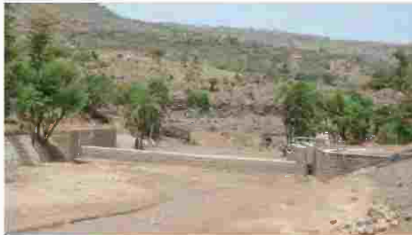
الشكل رقم (٢٠, ٦). سد مبني بالأحجار لحصد المياه في الوادي.
