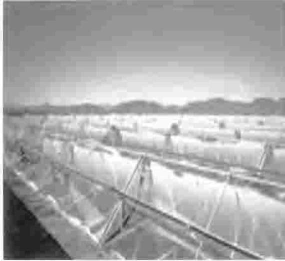
الشكل رقم (٧،٥). منظومة مجمعات حوضية الشكل موزعة لإنتاج الكهرباء (المصدر: وزارة الطاقة الأمريكية).
