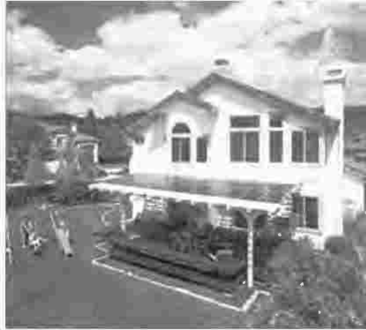
الشكل رقم (٧,٧). منظومة خلايا كهروضوئية تعمل كمظلة تطل على الحديقة الخلفية بينما تنتج الكهرباء للمول (المصدر: وزارة الطاقة الأمريكية).
