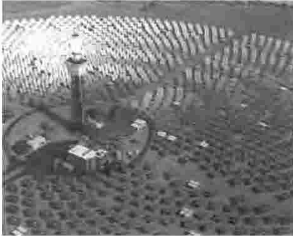
الشكل رقم (٧، ٦). إحدى المنشآت الأولى لإنتاج الكهرباء من الأبراج الشمسية (١٩٨٢ - ١٩٨٨م) (المصدر: شركة إديسون جنوب كاليفورنيا).
