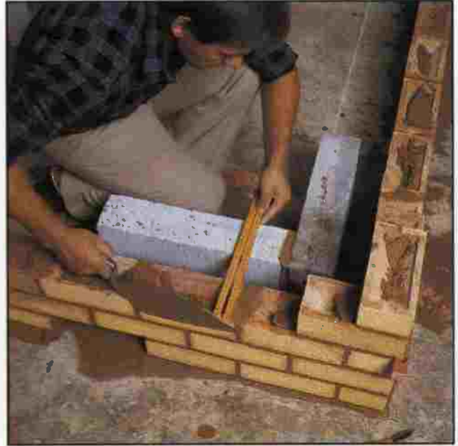
سيتم تعبئة الفراغ بين الجدران بالمادة الرغوية
