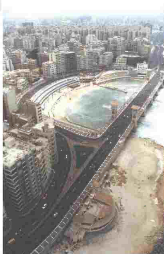
شكل (١٣٥) كوبرى سناتلى ( Stanley Bridge - Alexandria ) المصدر
