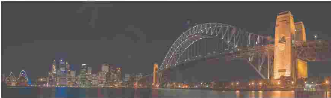
شكل (٢٣٨) التصوير البانورامي : جسر الميناء في سيدني Sydney Harbour Bridge night المصدر
