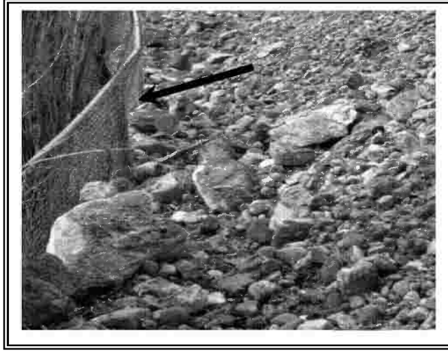
صورة رقم (٣١ب) الشبكات الحديدية المستخدمة لمنع وصول المواد
