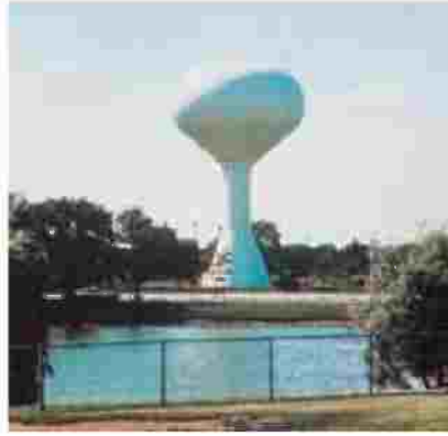
شكل ٦- ٤ برج مياه وهو جزء من النظام المائي في المدن الصغيرة والكبيرة، ويقوم بتخزين الماء وتوفير ضغط الماء اللازم.
