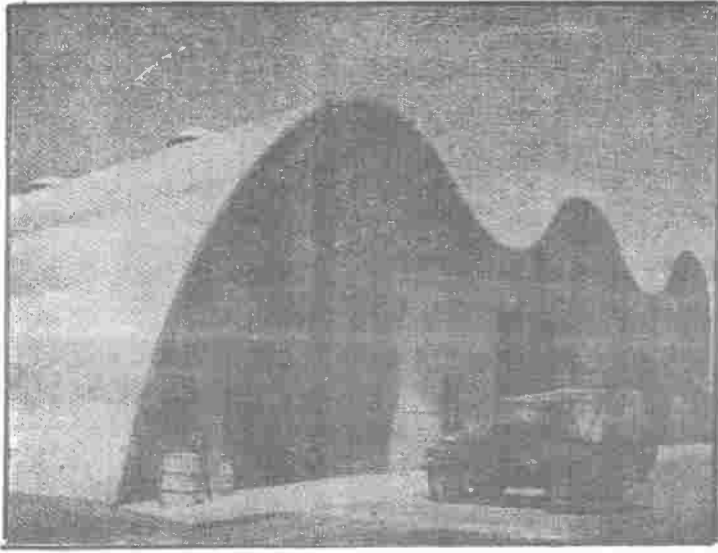
شكل رقم (م - ٨) سقف قشري من الخرسانة المسلحة
