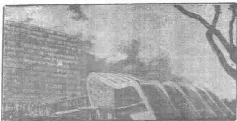
شكل رقم ( ٦ - ٢ ) سالة معارض من الخرسانة المسلحة
