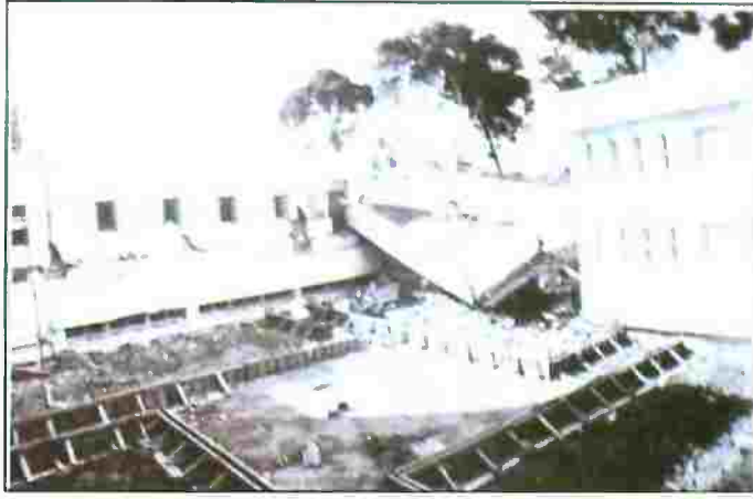
شكل (١٧): سقوط سقف أحد المباني بمدينة الأصنام الجزائرية نتيجة الزلزال، مصادفاً لقوله تعالى: «فخر السقف من فوقهم» (١) .
