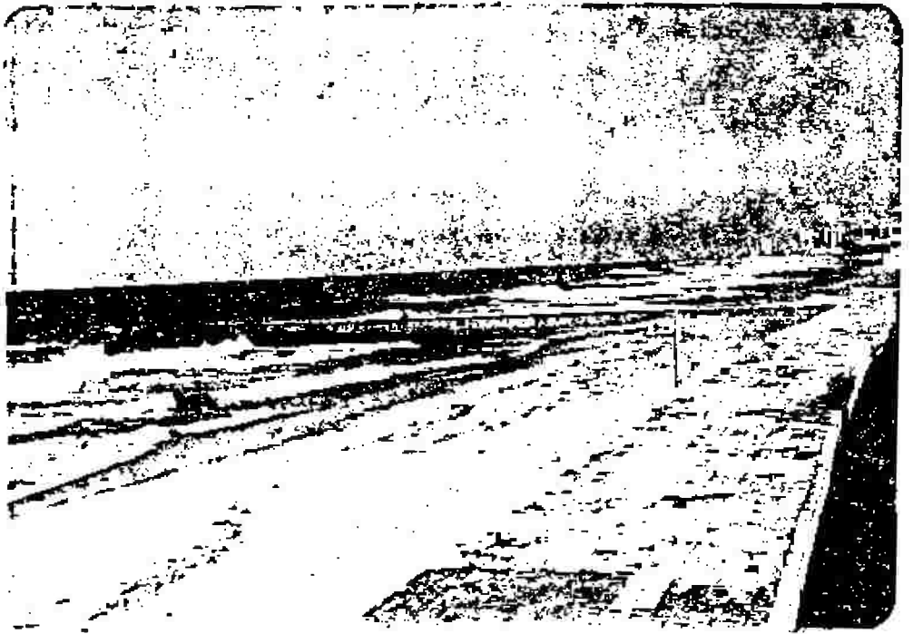
(صورة رقم ١) : تأثير حاجز الأمواج على عملية الترسيب التي تظهر بوضوح على الجانب الغربي للحاجز .
