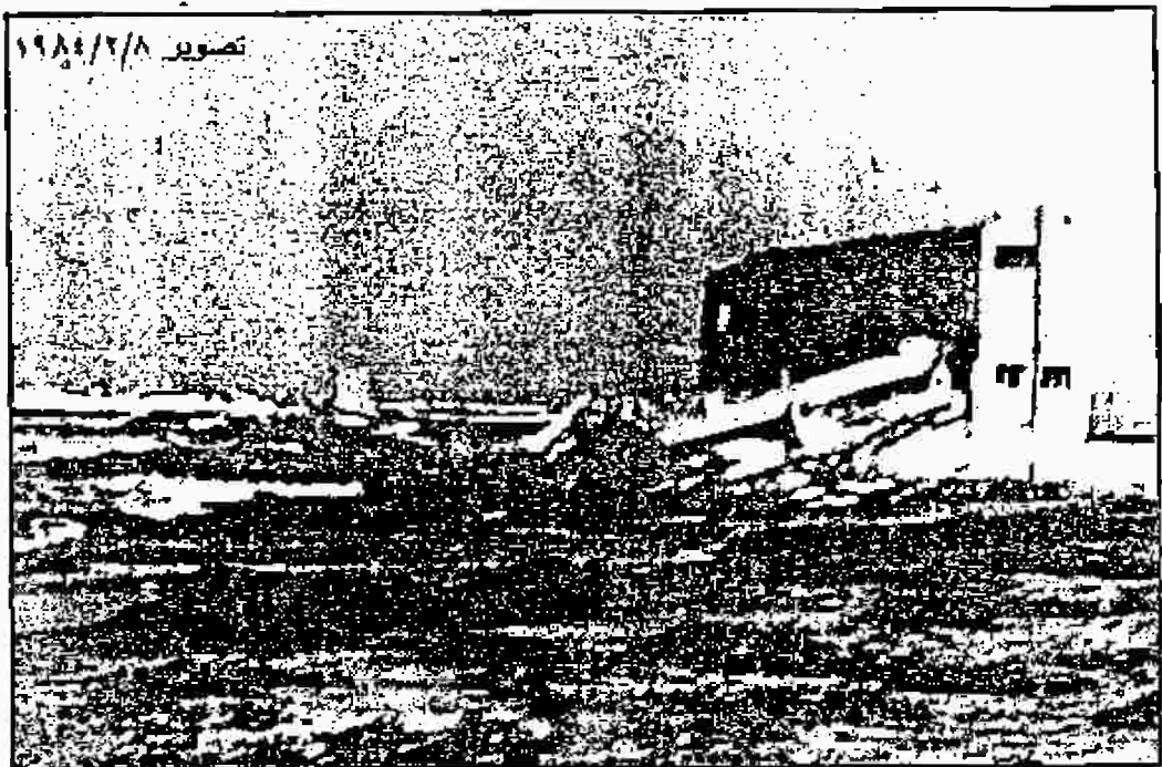
صورة (١) تراجع خط الساحل وانهيار المنشآت أمام هجوم الأمواج ويظهر فنار رشيد الحديث وقد لحظت به المياه
