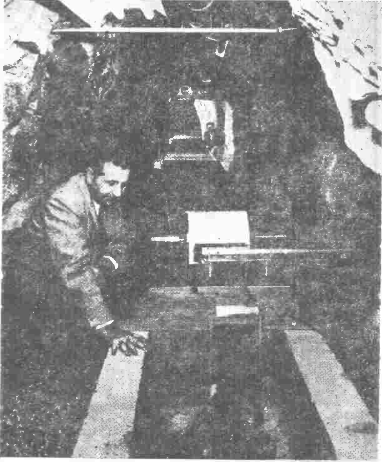
الدكتور هيجو بنيوف من معهد التكنولوجيا بكالفورنيا يقوم بتشغيل آلة السيسومتر التي وضعت في جبال الأنديز خلال السنة الجغرافية الدولية لتسجيل وقياس التغيرات التي تعترى السطح الأعلى للقشرة الأرضية .
