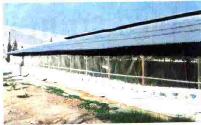
شكل (٨) العنابر المفتوحة ذات أسلوب الستائر
