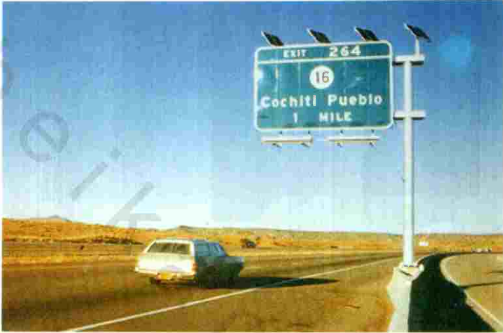
شكل ( ١٢ ) إضاءة العلامات الإرشادية للطرق بالطاقة الشمسية .
