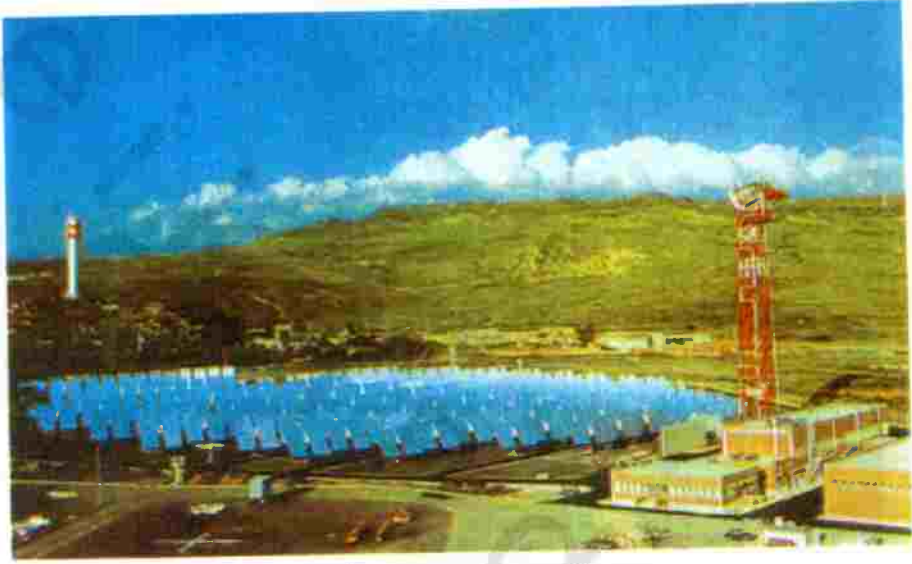
شكل ( ٧ ) نظام المستقبل الشمسى المركزى
