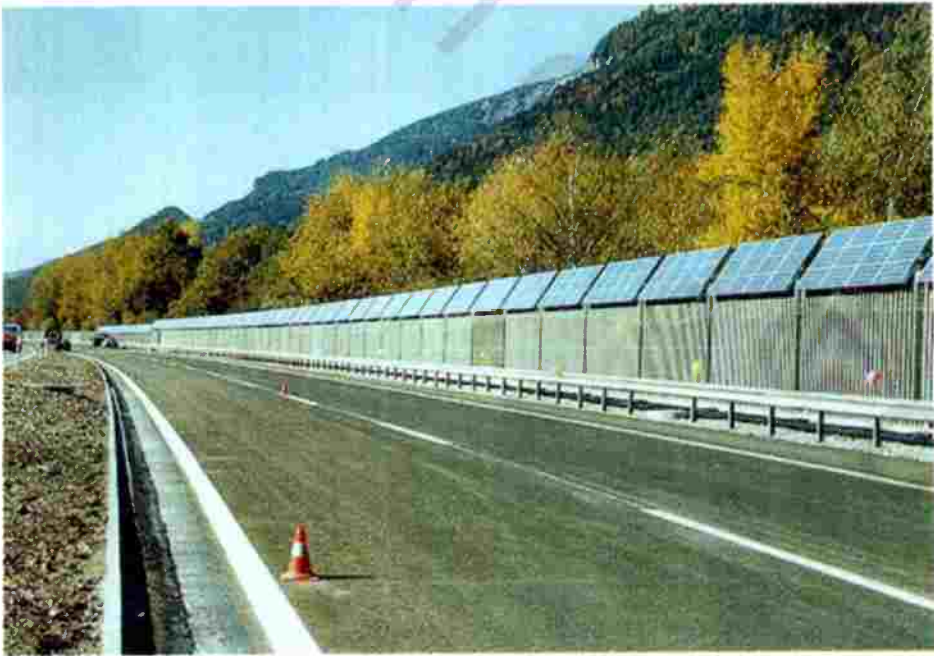
شكل ( ١٦ ) مصفوفات شمسية على طول الطريق بسويسرا لتوليد كهرباء للاستخدامات العامة .
