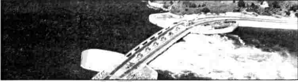
(شكل ٦) تفريغ المياه من خلال فتحات السد من المنسوب العالي (البحر) إلى المنسوب المنخفض (الخليج)
