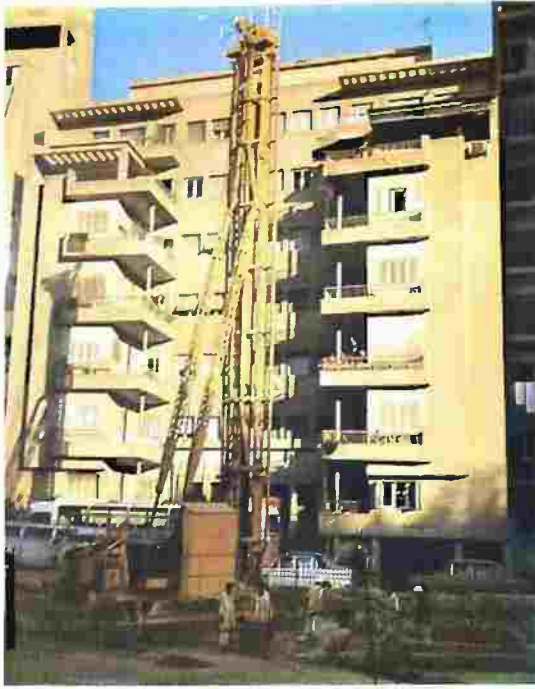
بدأت شركة (حسن علام، فرانكي بلاتون) للأساسات عملها في موقع عام بجوار سين سين لانتشار مبنى للكتائب الإدارية والنظام الحديث للأساسات لا بسبب صرنا ولا اهتزازات للباقي المجاورة.
