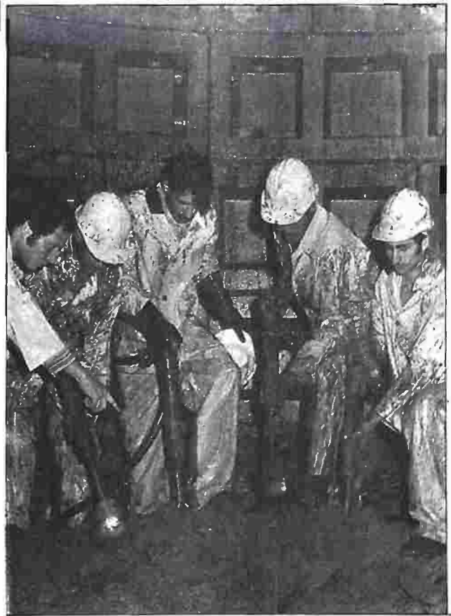
● الحفر بالترامكس الميكانيكية بطريقة ضغط الهواء، لي بئر التشغيل فهذه الحفر النفق الألفي تحت قناة السويس، على عمق ٤٣ متراً تحت سطح الأرض.
