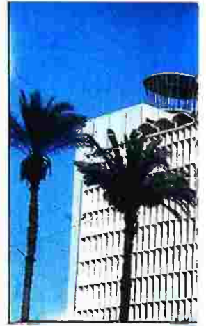
أعيد ترميمه في ٢ شهر.
