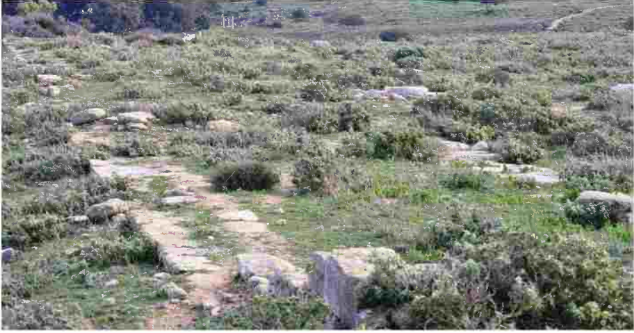
أساسات المبنى العملاق الخاص بالموقع
