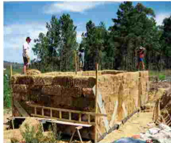
تبين هذه الصورة المرحلة الأولى في بناء منزل القش.
