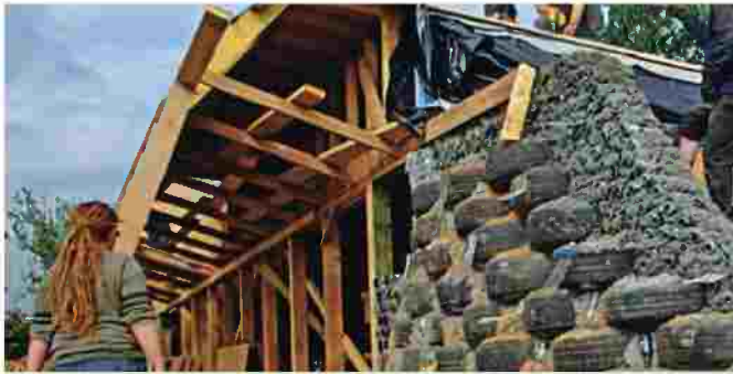
يعيد منزل الأرض استخدام إطارات قديمة للسيارات مملوءة بالتراب في بناء الجدران.
