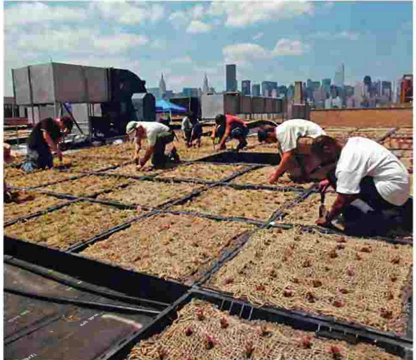
عمال يبنون سطحاً أخضر على سطح مبنى في مدينة نيويورك.
