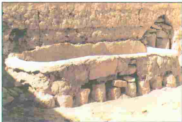
صورة (١٢): حوض في وسط البيت لفصل الأيدي بعد الأكل مبني من الحجر ومطلي بالصهروج الأخضر
