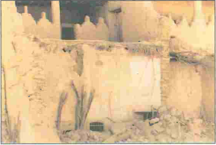
صورة (٨): جزء منهدم من منزل قديم يلاحظ تدرج سماكة اللبن من أسفل إلى أعلى حيث تقل السماكة كلما اتجهنا إلى أعلى
