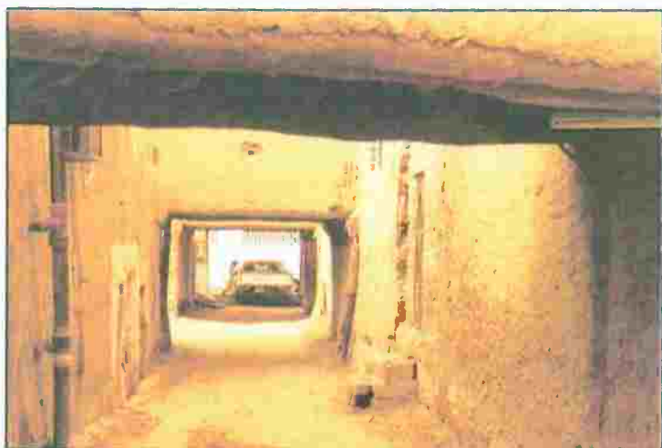
صورة (٥): سكة (طريق) قديم تظهر فيه المجابيب
