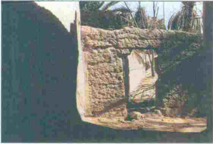
صورة (٣١): جدار مزرعة مبني من عروق الطين ويجانبه جدار يظهر فيه: ١- مليص بالطين (فوق) ٢- جزء مصبوع (وسط) ٣- جزء مشبع (أسفل)
