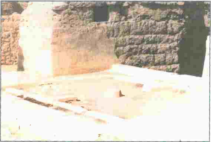
صورة (٣٤): اللزاو وهو ما تصب الغروب فيه ليتجه الماء إلى المزرعة
