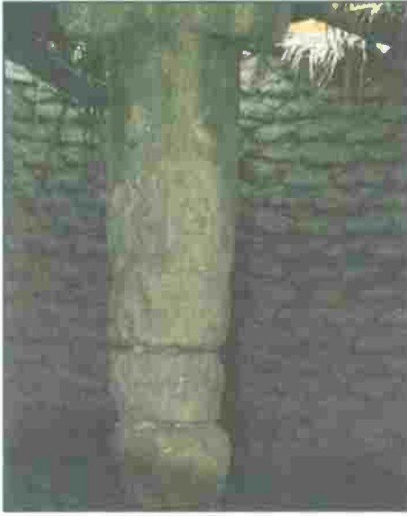
صورة (٢٧): عمود من الحصن في وسمل حجرة يلاحظ فيها أنواع من الحجر وهو: ١- حجر خرز (أساس العمود) ٢- حجر القنايع (فوق العمود).
