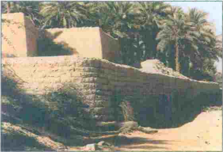
صورة (٣٢): مزرعة جدارها مطوي بحصى قديم (مذيل)
