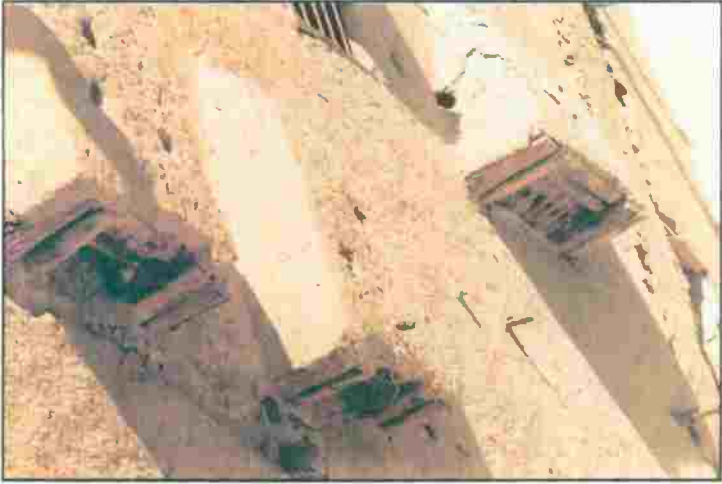
صورة (٦): واجهة منزل تظهر فيه الطرمة ويدل على ضخامة البيت عدد الطرّمات التي فيه
