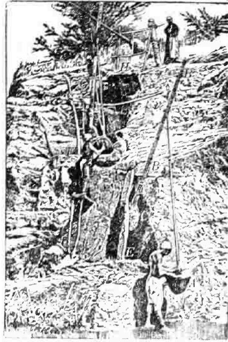
شكل : ١٨ - الشادوف المصرى - أقدم أنواع الاجهزة لرفع مياه الابار - يستعمل لرى الحقول •
