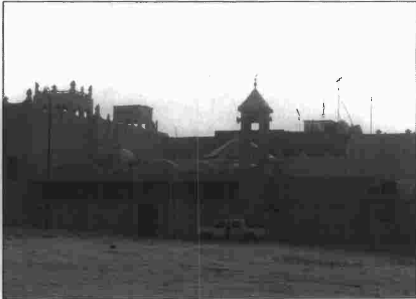
صورة مسجد الدبس (الفاتح) من الخارج بعد الترميم
