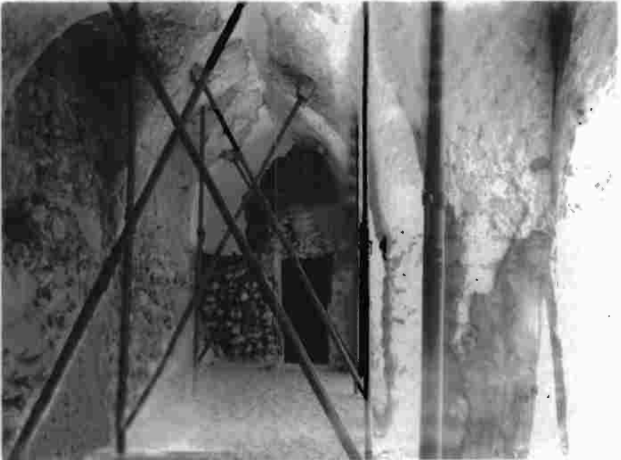
صورة للرواق الشمالي من الداخل والباب الظاهر به هو باب الغرفة أثناء الترميم ١٤٢٨ هـ
