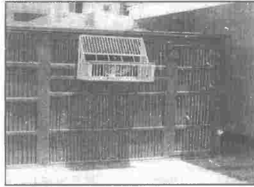
جزء من لوفت اللواء /محمود سعيد (بالمعادي) ويلاحظ توافر التهوية عن طريق سدايب الخشب البغدادي .. بالإضافة إلى نظافة اللوفت
