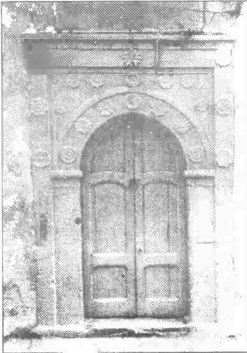
صورة ٢٩ : أحد المداخل بمنزل قديم بطرابلس
