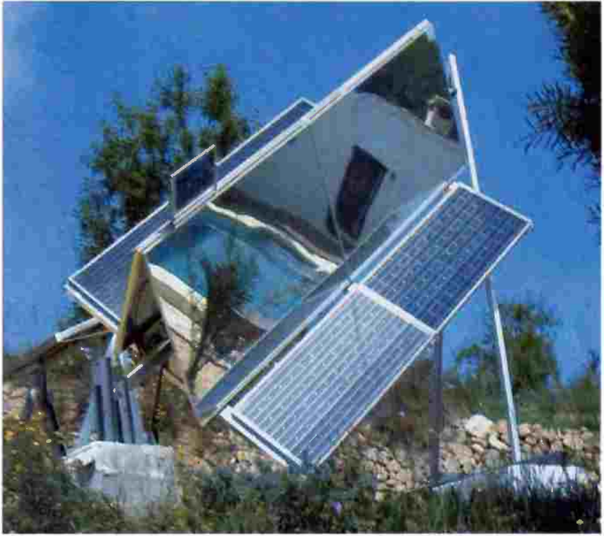
شكل (٧) : أحد المراكز المفصلية للطاقة الشمسية في منطقة جبلية استخدمت فيه الخلايا الشمسية والمرايا والصفائح المعدنية اللمعة ويلاحظ أنه يمكن توجيهه بطريقة يدوية بسيطة
