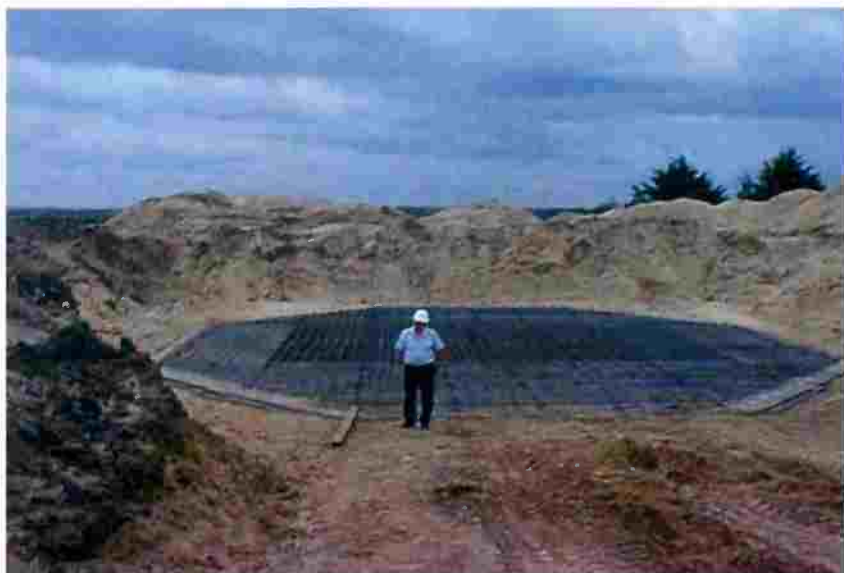
شكل (٥ - أ) : بناء القواعد الخرسانية أسفل الأرض حتى ظهورها على السطح
