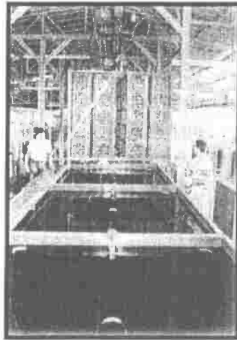
نقل باليات الثمار بالأوناش إلى ماء ساخن ثم إلى ماء عاى . (صورة من زيارة المكسيك ومزارع المانجو - مشروع استخدام ونقل التكنولوجيا) .
