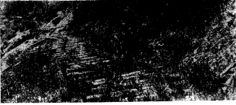
(زحف والتواء خطوط السكك الحديدية بعد الزلزال)
