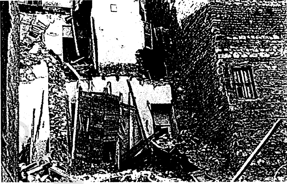
الشكل ٨٢ - أبنية متضررة مبنية بخليط من الحجارة والبلوك الطيني (المصدر ٩٣).
