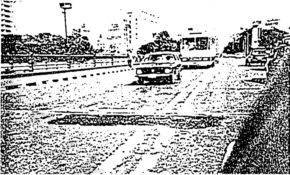
الشكل ٩٢ - جسر قديم مبنى من جوائز فولاذية يقطع نهر النيل في القاهرة فقد جزءاً من غطاءه البيتوني أثناء الزلزال (٩٤).
