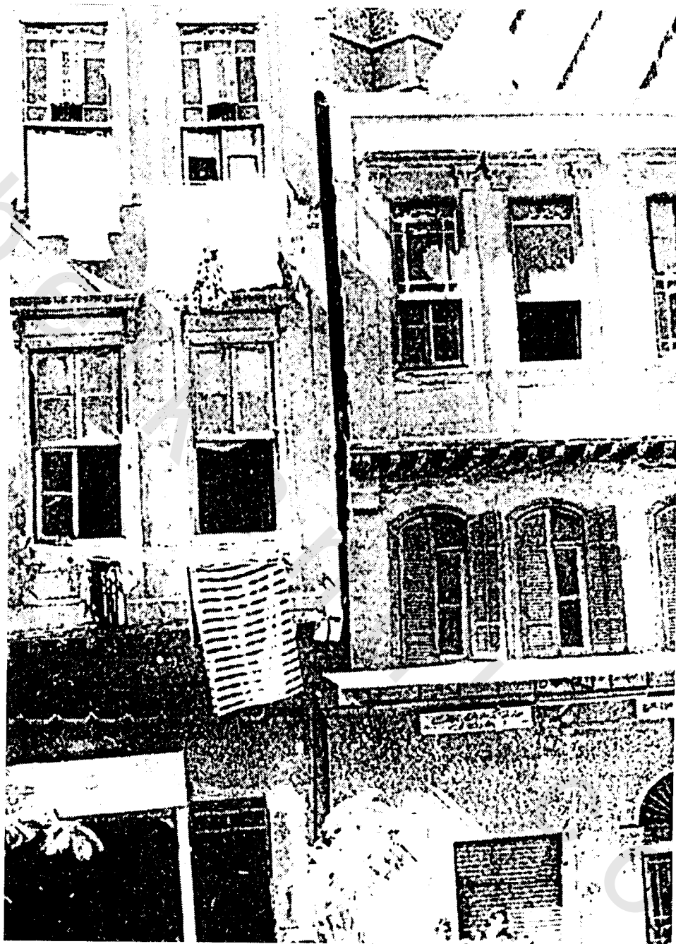
الشكل ٨٥ - انفصال المباني عند فواصل التمدد وميلان بعضها (المصدر ٩٣).
