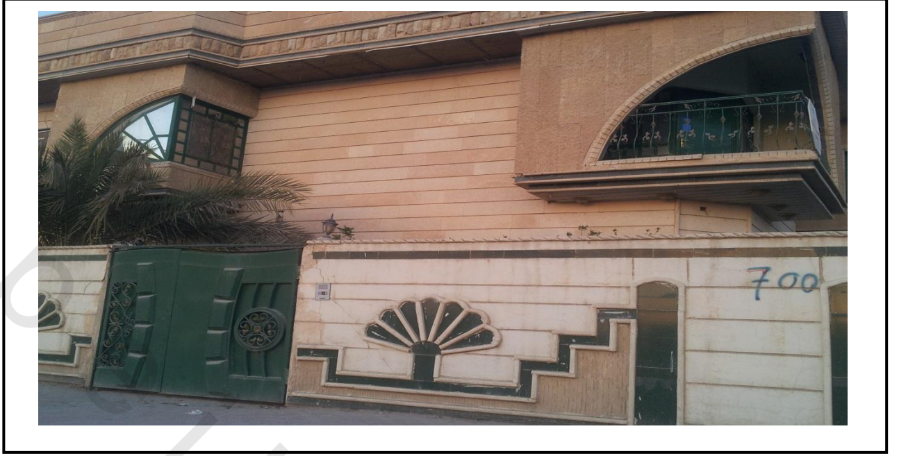
صورة رقم (٣) استخدام الطابق المفخور في البناء في مركز الكوفة بصورة واسعة .تصوير الطالبة، بتاريخ ٢٠١٤/٢/٢٢م
