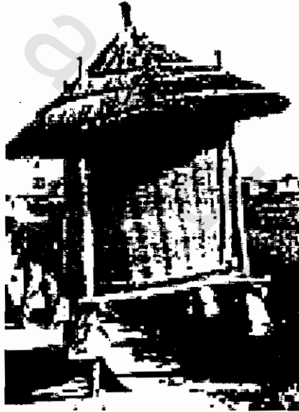
شكل (٥-٣): مصدات الفئران المصنوعة من الألواح المعدنية و المثبتة علي مخزن
