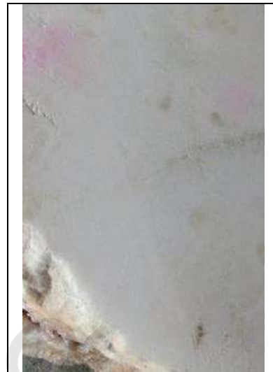
شكل (٦٧) اثناء عمليات الصقل
